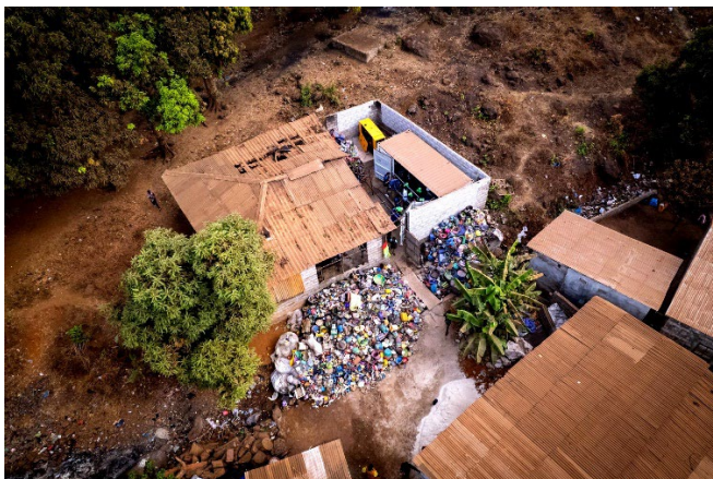
Atelier de recyclage BGS à Conakry, Guinée
